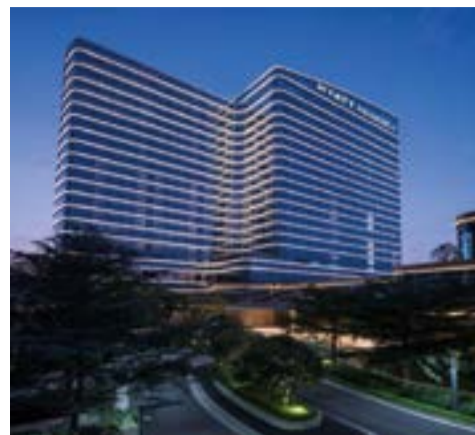
福州凯悦酒店机电安装工程
