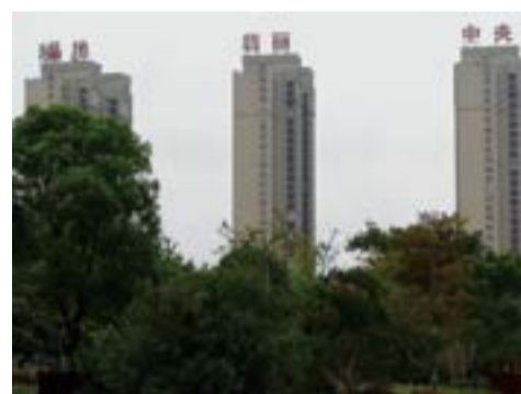
扬州晶丽项目消防工程
