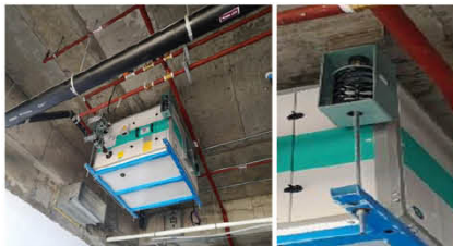
图 5.6.2.3 现场机组的吊装 图 5.6.2.4 现场吊装支架局部图
